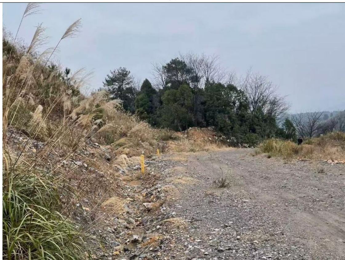
输水管道现状
